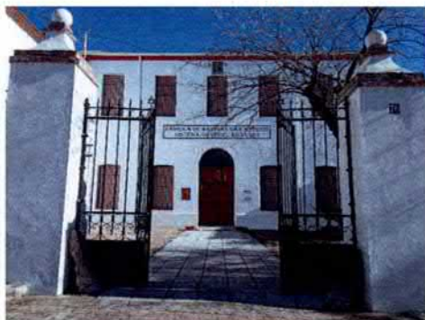
Fachada principal de la Fábrica "San Antonio." (Fotografía: Isabel Silva Cano).
