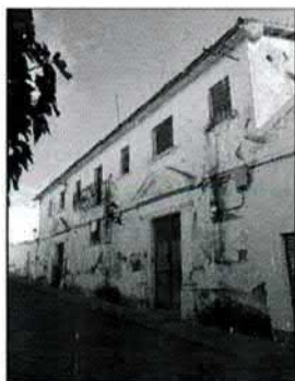
F13 Fachada de la antigua Casa del Pueblo de la UGT en 2003 (RM)
