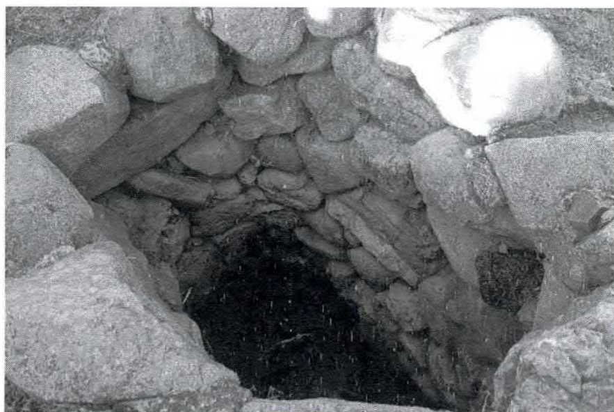
Detalle de la construcción del Pozo Nuevo.
