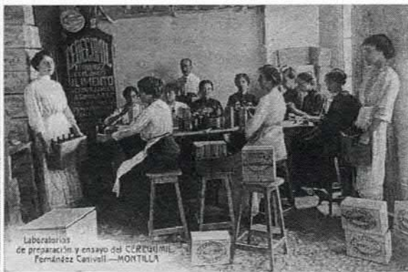
Fábrica del Ceregumil. Zona de envasado.
