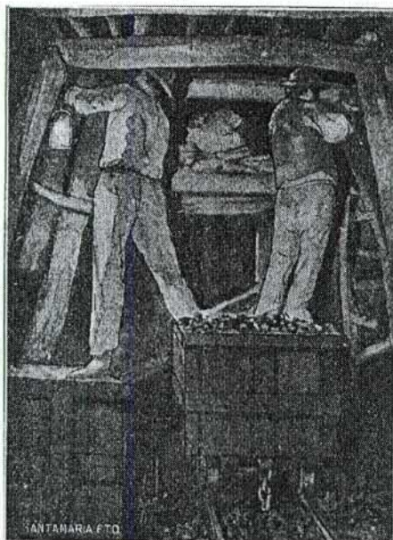
F 10 Entibadores en una galería minera.
