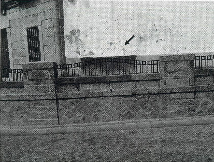
Tras el cegado del pozo y la reconstrucción de la pared, hasta hace poco podía apreciarse el lugar de su ubicación tal como lo delatan el tramo del color distinto del zócalo y unas leves huellas del enfoscado de la pared.
