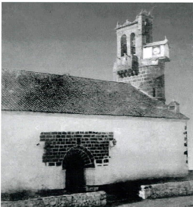
Torre de la iglesia de San Sebastián de Torrecampo, antes de su destrucción en 1905. La "casita" blanca de la derecha era un reloj colocado a finales del siglo XIX.
