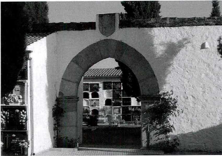
Arco de entrada a la iglesia del antiguo convento de Nuestra Señora del Socorro que se conserva en el interior del cementerio de Pedroche.
