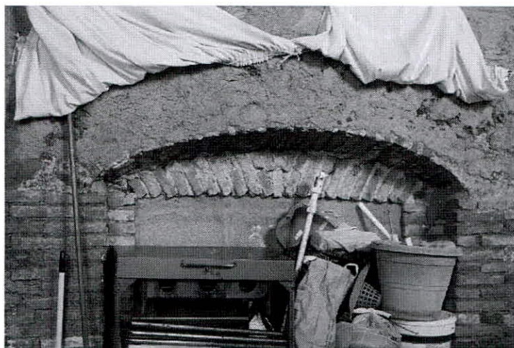
Vista interior de la parte superior de la antigua puerta de acceso, con el típico arco de descarga formado por una rosca de ladrillos, junto al que se sitúa el dintel exterior recto, cubriendo ambos el espesor del muro. La oquedad resultante como consecuencia del tapiado de la puerta, ha permitido la formación de un pequeño cuchitril, tapado con su correspondiente cortina que fue recogida para hacer la fotografía.
