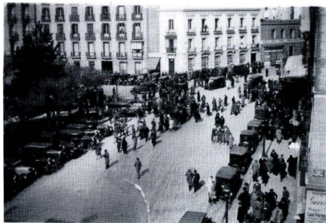
Sevilla, Plaza de Cuba, Calle de los Remedios, Calle Betis 14
