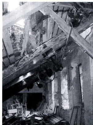
Maquinaria de transmisión de la fuerza motriz en la nave de telares.
