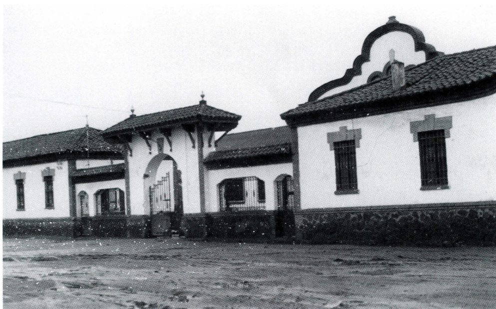
Fachada del Matadero Municipal
