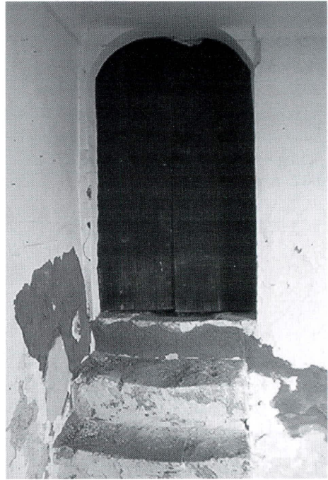
Puerta dintelada de acceso a dormitorios con escalera de mampostería
