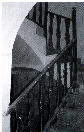
Escalera de madera con peldaños de ladrillo cocido
