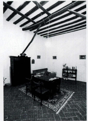
Sacristía de la antigua iglesia conventual de Santa Teresa
