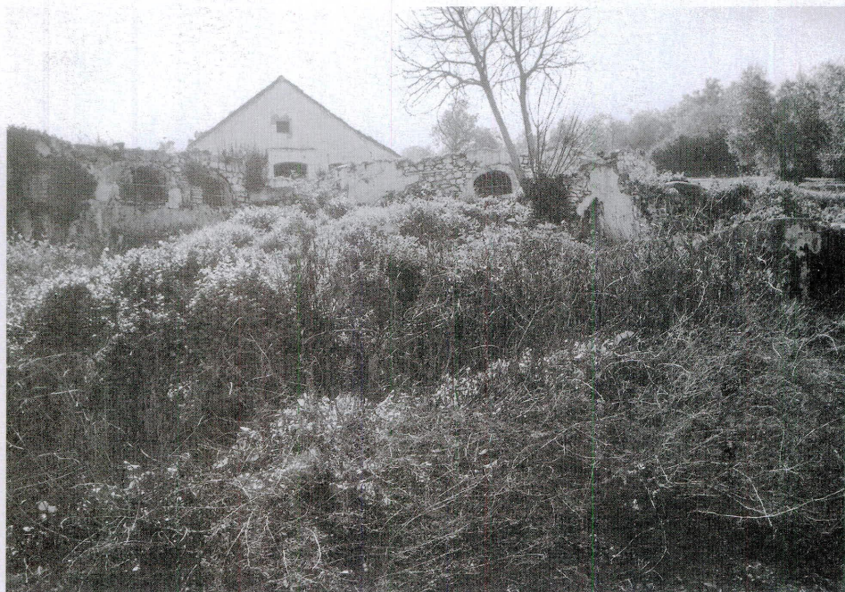
Los Atanores, estado actual. Depósitos y antigua casa del guarda.
