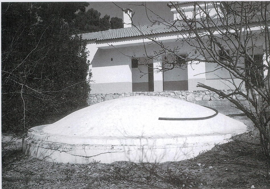
Depósito de El Borbollón.
