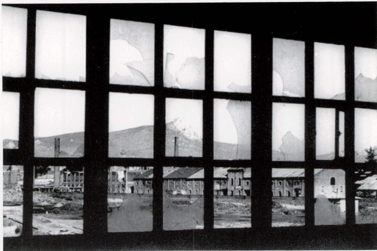
1992. Explanada de descarga de minerales de la Fundición de Plomo, Fábrica de Productos Refractarios y Peñón de Peñarroya, desde las oficinas.
