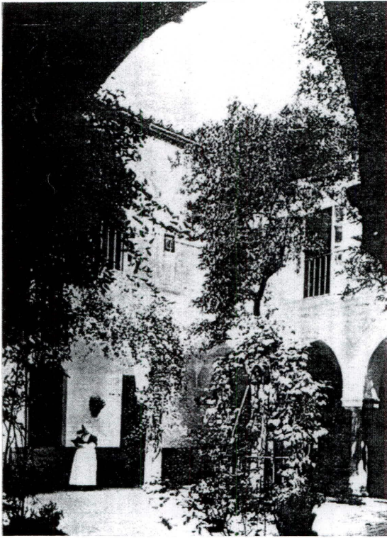
Patio del Hospital de San Juan de Dios. Andalucía Ilustrada (junio 1926).
