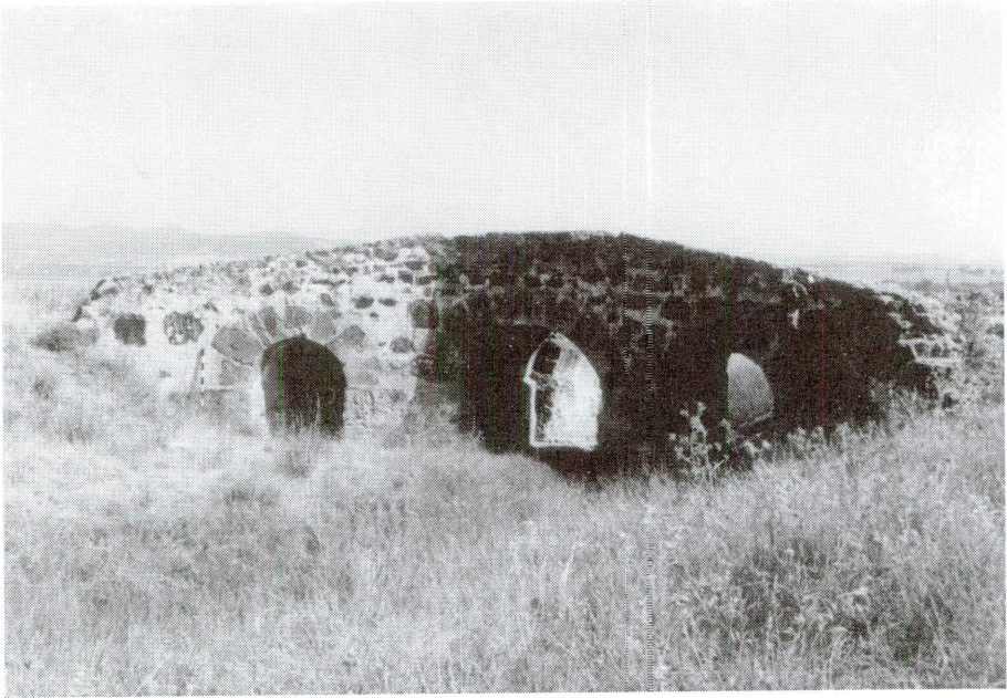
Figura III. Puente romano sobre el arroyo de los Mantequeros. (Tramo Cordel de Alcolea).
