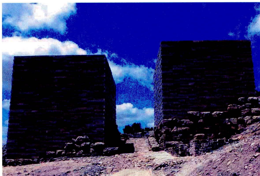
La puerta oriental tras su restauración en 2011.
