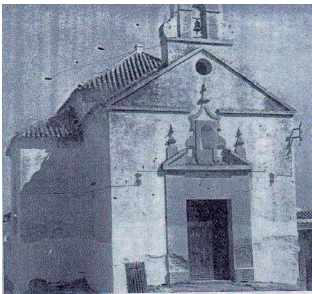
Estado en que se encontraba en 1980 la ermita de San Sebastián.
