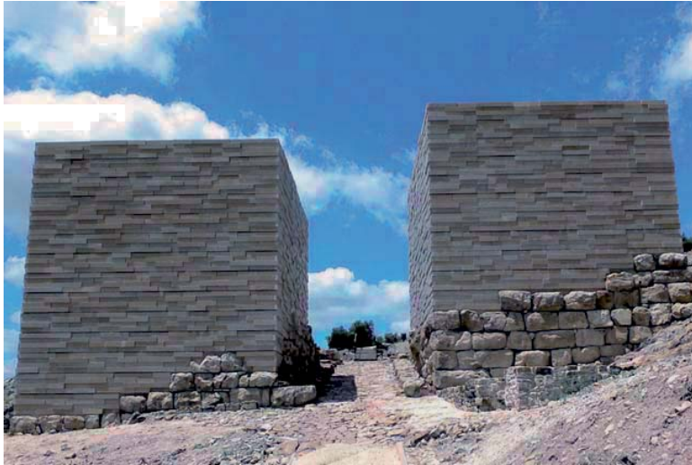
La puerta oriental tras su restauración en 2011.
