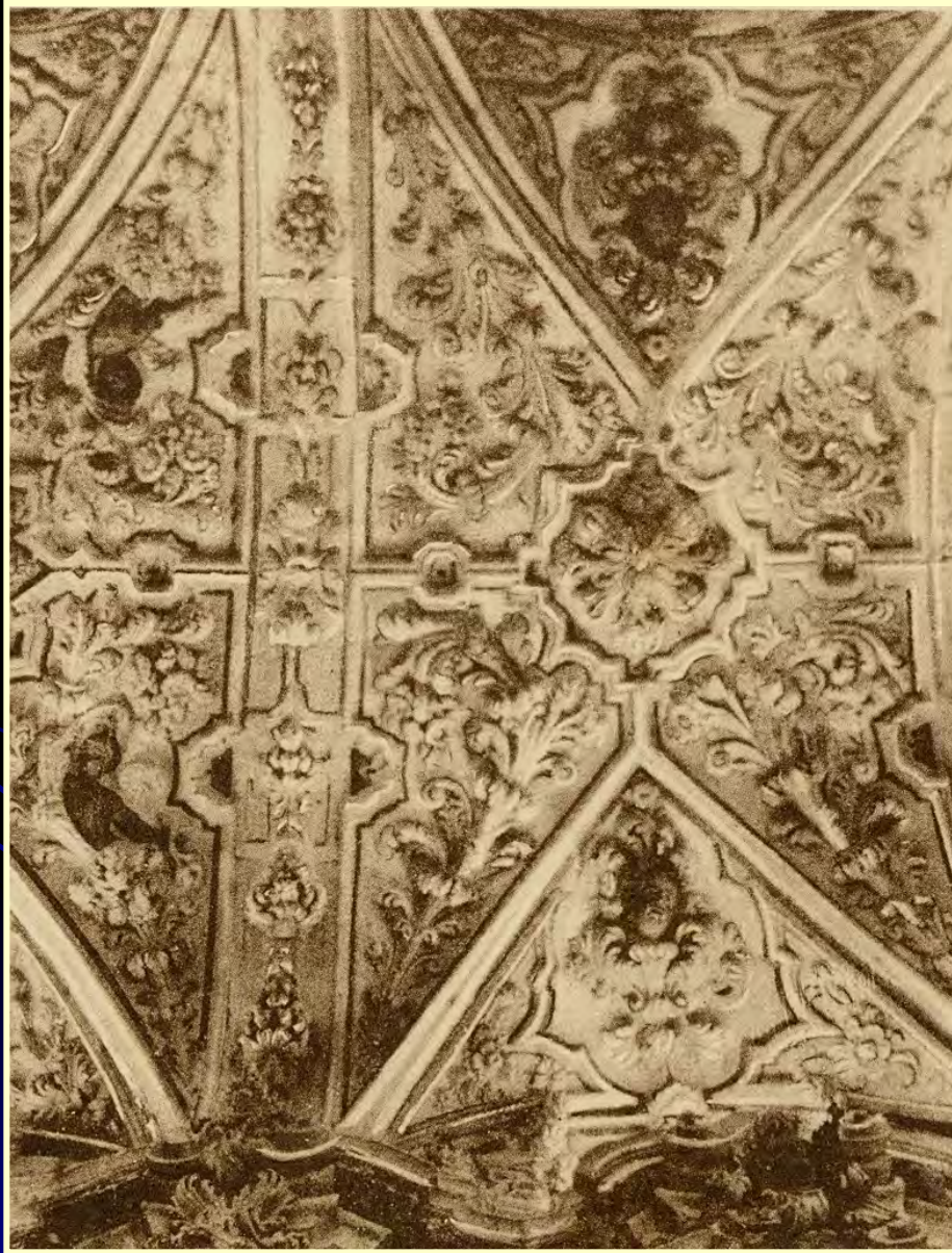
Iglesia de la Aurora. Techo.
