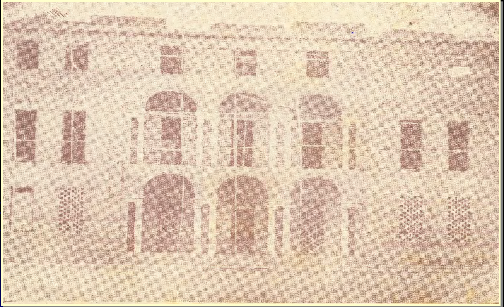
Construcción del Palacio Municipal. (Foto: Medina). Programa de la Feria Real. Priego de Córdoba. Septiembre 1949.
