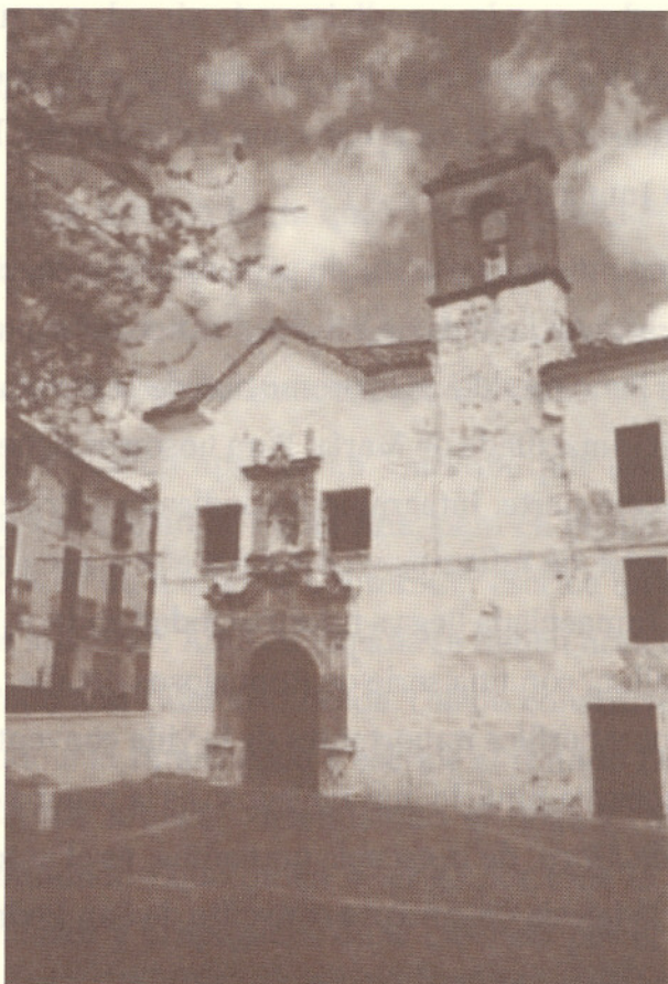
Aspecto de la plaza de San Pedro antes de 1992. (Foto: E.A.O.)
