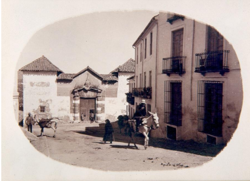
Carnicerías municipales. Edificio del siglo XVI.
