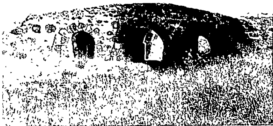
Figura III Puente romano sobre el arroyo de los Mantequeros (Tramo Cordel de Alcolea)
