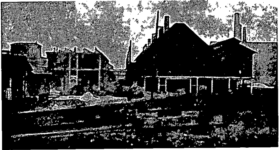
Fábrica de cinc (derecha) y Fábrica de Productos Refractarios
