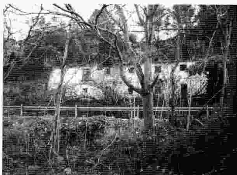
Casas para los trabajadores en la zona alta.
