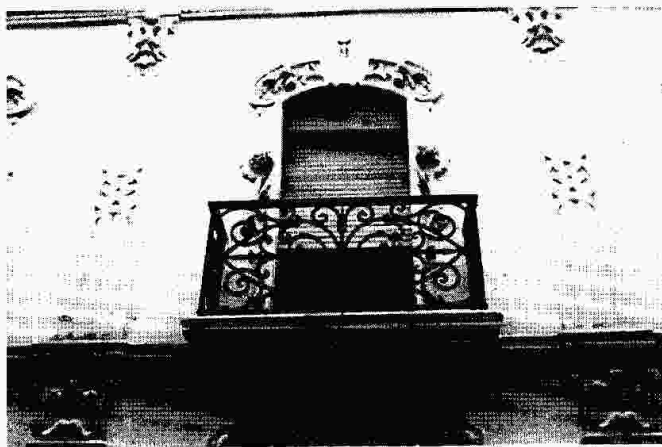
Detalle de una de las ventanas.
