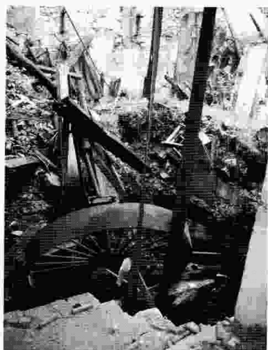
Restos de la central eléctrica.
