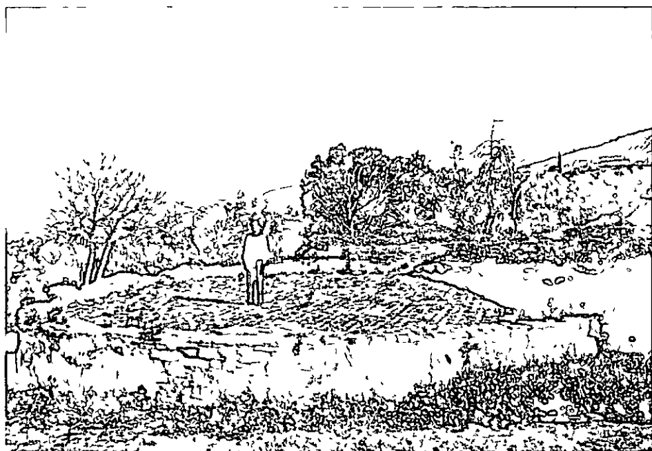
Cubierta de uno de los depósitos de los Atanores
