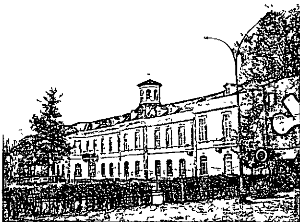
Edificio de la antigua Dirección de la SMMP
