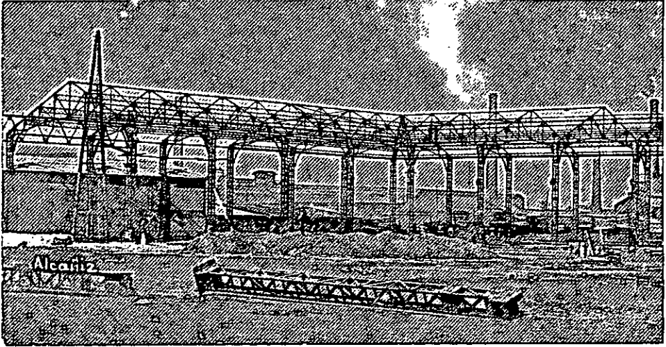
Almacén Central en construcción
