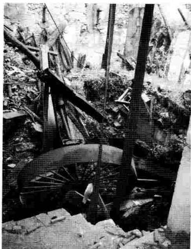
Restos de la central eléctrica.
