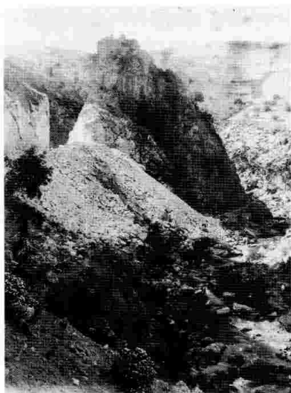
Corte de la sierra para dar salida a la carretera. (foto de la época)
