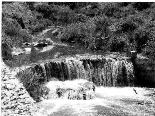
Presa construida para conseguir el salto de agua. Estado actual.
