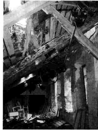
Maquinaria de transmisión de la fuerza motriz en la nave de telares.
