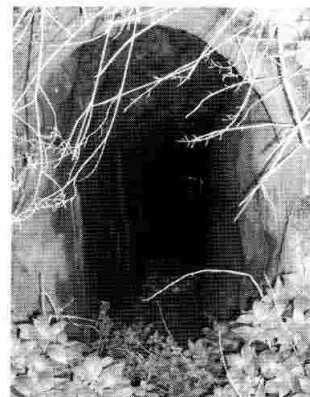
Túnel por el que llegaba el agua a la turbina.
